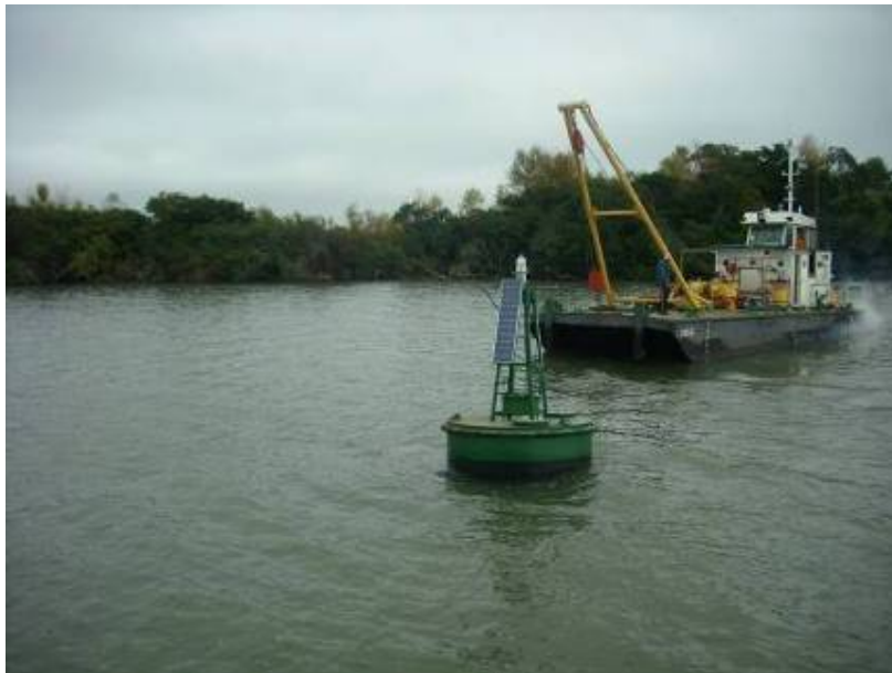
Fig. 1 Embarcación de la DNVN –RA realizando maniobras de colocación de boyas.
