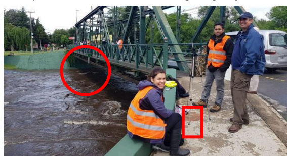
Figura 2 .- Estación hidrométrica en el tramo del Río Santa Rosa en el puente de Hierro (Cuenca Alta del Río Tercero). En círculo se indica el sensor de nivel automático y en el recuadro se muestra el sitio óptimo para grabar videos
