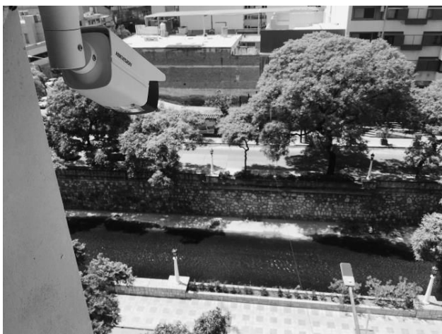
Figura 2. –Cámara de la estación fija LSPIV del arroyo la Cañada ubicada sobre la fachada del Ministerio de servicios Públicos
