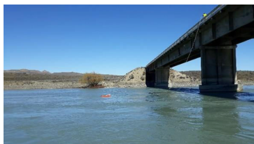
Figura 3.- Sección de medición en el río La Leona (La Leona Norte). Puente Ruta Nacional N°40.
