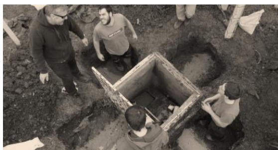
Figura 3.- Alumnos construyendo lisímetro.
