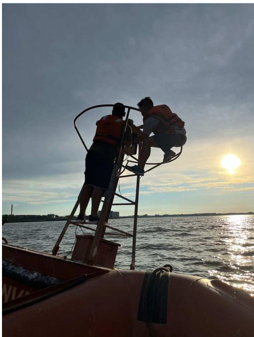
Las tareas previstas para el mantenimiento de las boyas ya instaladas consisten en: verificación del posicionamiento y reposicionamiento; verificación del funcionamiento lumínico y característica asignada; pintado de la superestructura, reparación y/o reemplazo de letreros, baterías, fotocélulas, cables, paneles solares, cadenas y grilletes.
