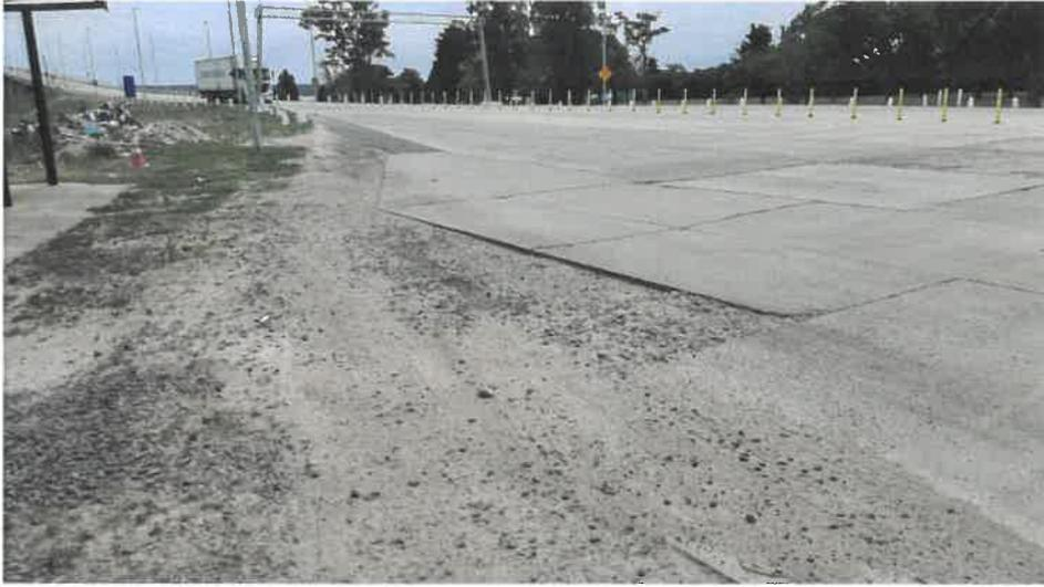
**Foto 2:** Losas fisuradas y sin juntas, banquetas utilizadas para el ingreso a cabinas de Peaje.
