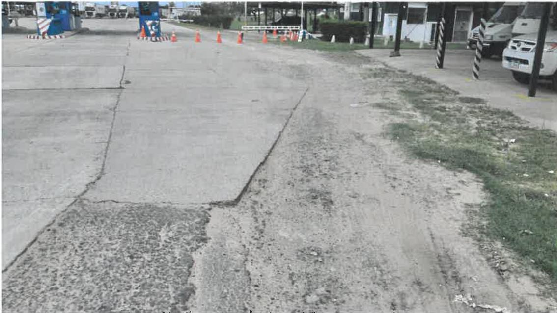
**Foto 3:** Losas sin juntas, banquetas utilizadas para el ingreso a cabinas de Peaje.
