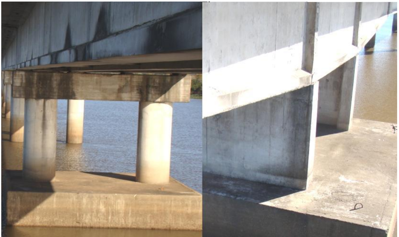
Figura 6. Pilas del viaducto Argentino del Puente Libertador General San Martín.
