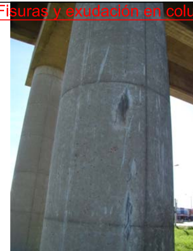
Foto 3: Fisuras y exudación en columna 1
