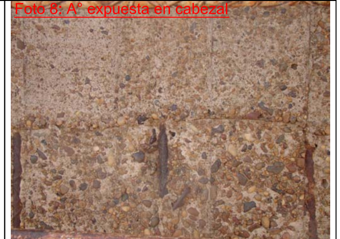
Foto 12: Recubrimiento saltado en cabezal
