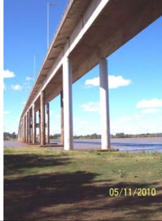
Foto 2: Tramo 20 y 21, vista lateral
