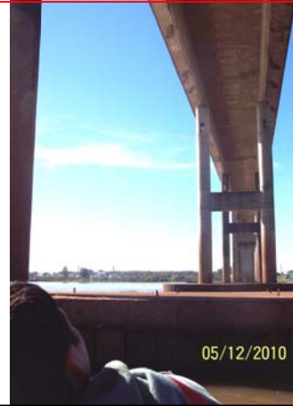
Foto 2: Cara inferior losa de tablero. Tramo 19
