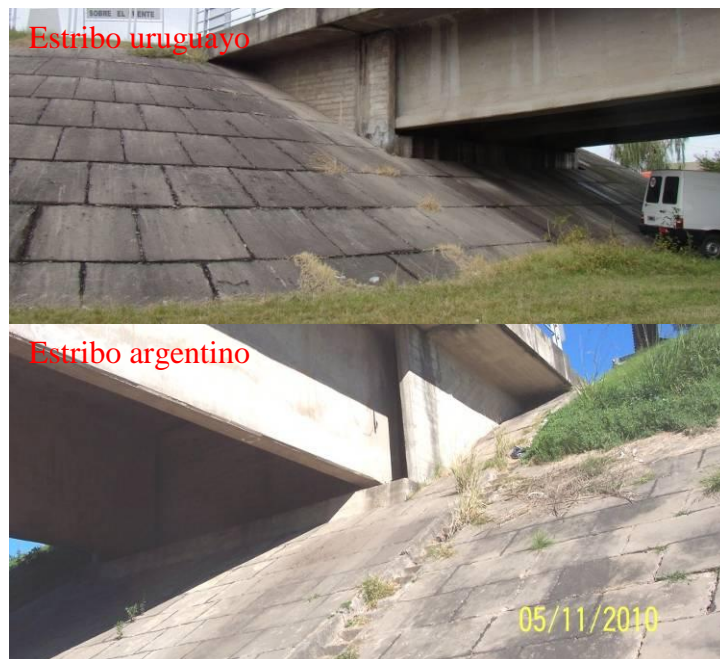
Figura 35. Protección de los terraplenes de acceso.
