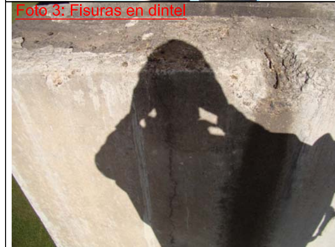
Foto 5: Fisuras en dintel
