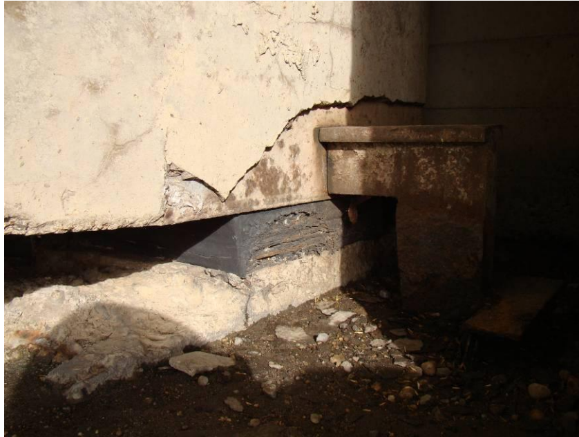
Figura 25. Apoyo sobre el Estribo 2 (Lado Argentino).
