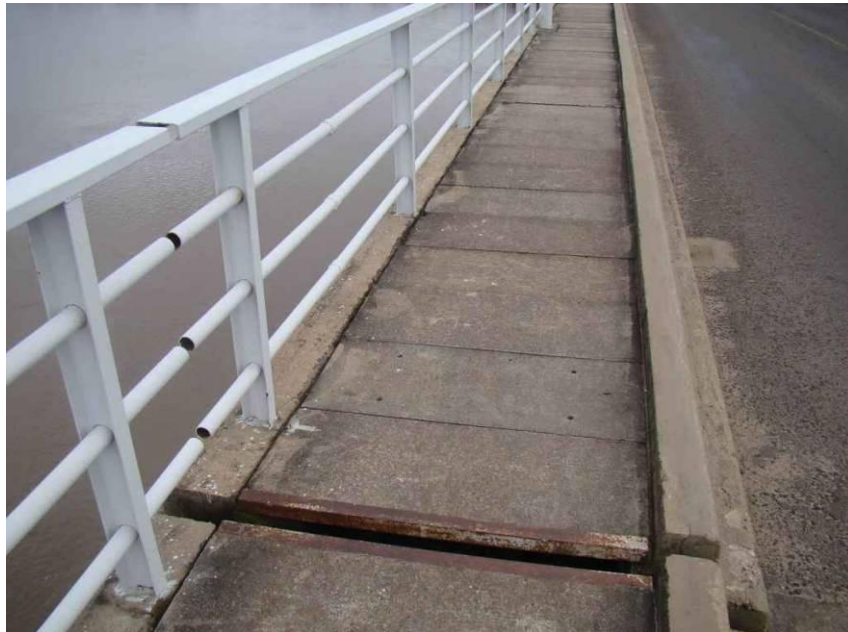
Figura 40. Vista cara superior de vereda peatonal y baranda metálica en buen estado.
