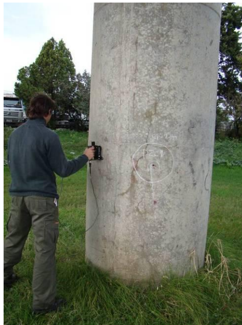
Figura 28. Ensayo de Integridad del Hormigón (Pulso Eco) en Pila 2.
