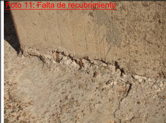
Foto 12: Falta de recubrimiento
