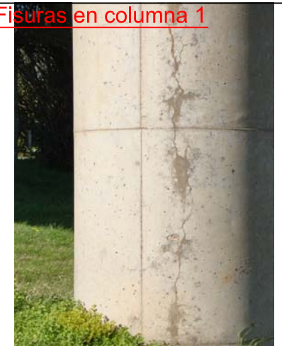
Foto 4: Fisuras columna 1
