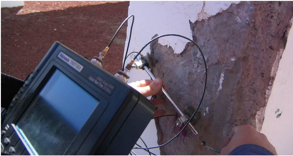
Figura 4. Instrumento utilizado para el registro de la profundidad de fisuras.
