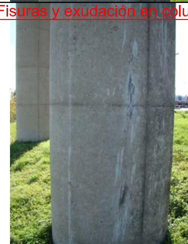
Foto 5: Fisuras en columna 2
