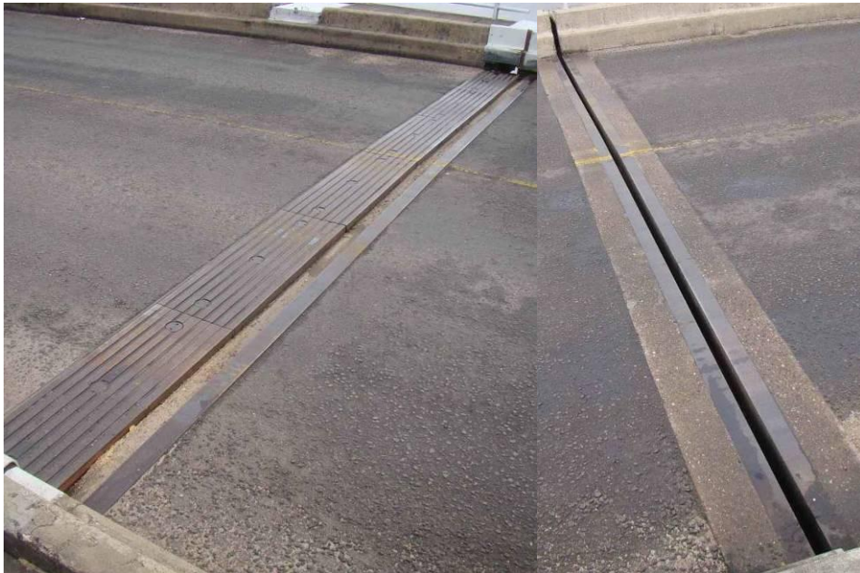
Figura 38. Dispositivos de juntas de dilatación.
