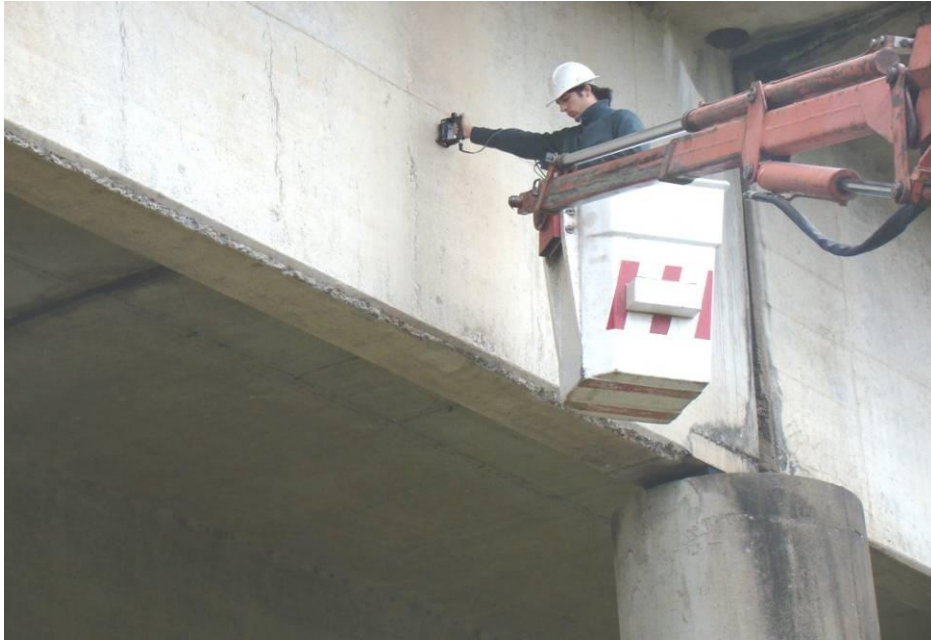
Figura 34. Ensayo para determinar la integridad del hormigón (Pulso Eco) en tramo 37.
