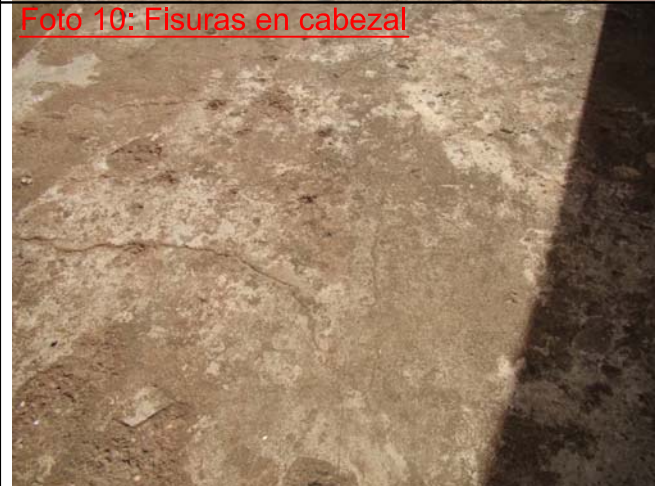
Foto 11: Fisuras en cabezal
