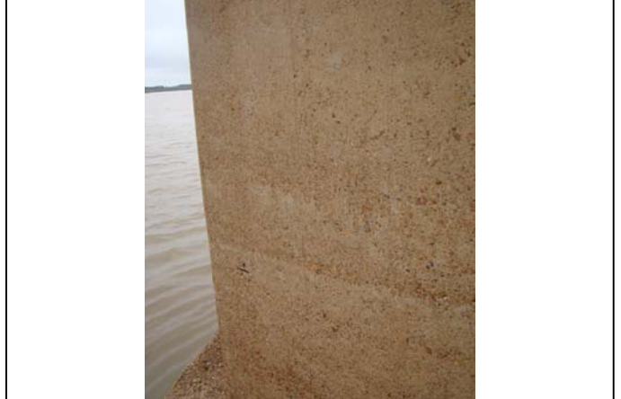
Foto 12: Fisuras, tabique 1 lado argentino
