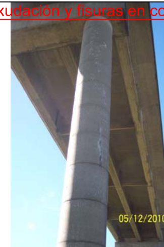
Foto 3: Fisuras en dintel
