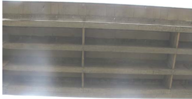
FOTO 1: Cara Inferior del Tablero.
