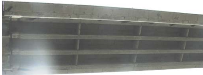
FOTO 1: Cara Inferior del Tablero.
