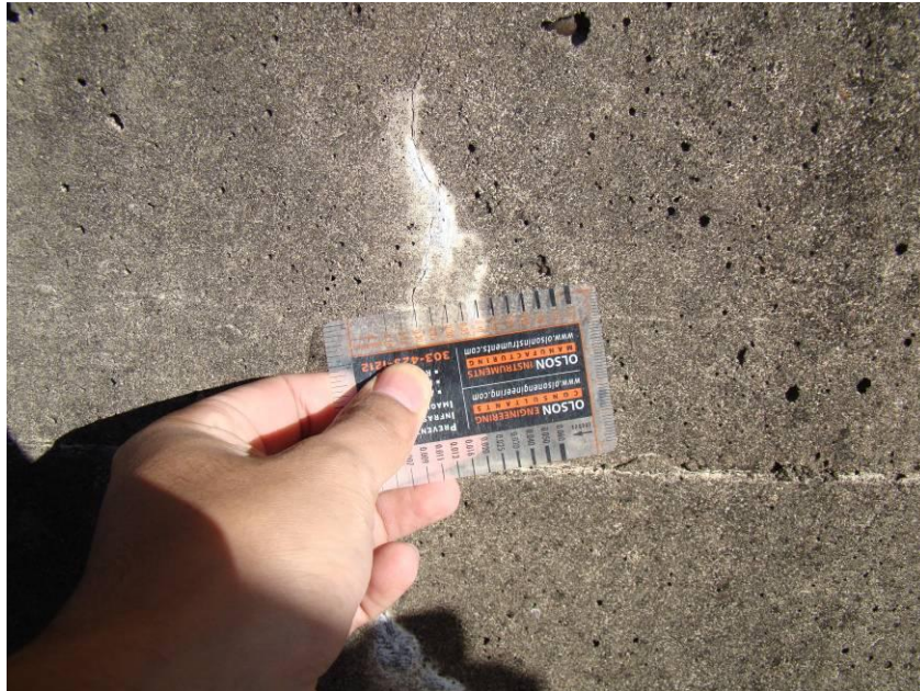
Figura 14. Fisura y exudación en dintel de la Pila 32.
