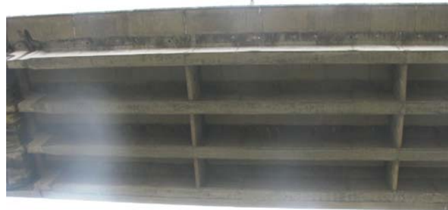
FOTO 1: Cara Inferior del Tablero
