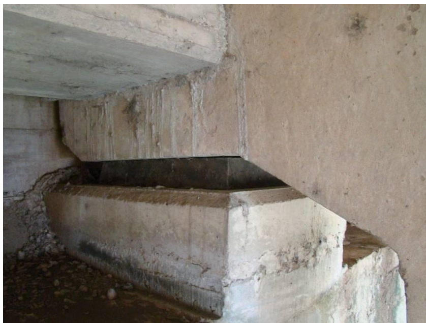
Figura 17. Vista de uno de los dispositivos de apoyo sobre el puente la Pila 1 de la estructura (Estribo 1).
