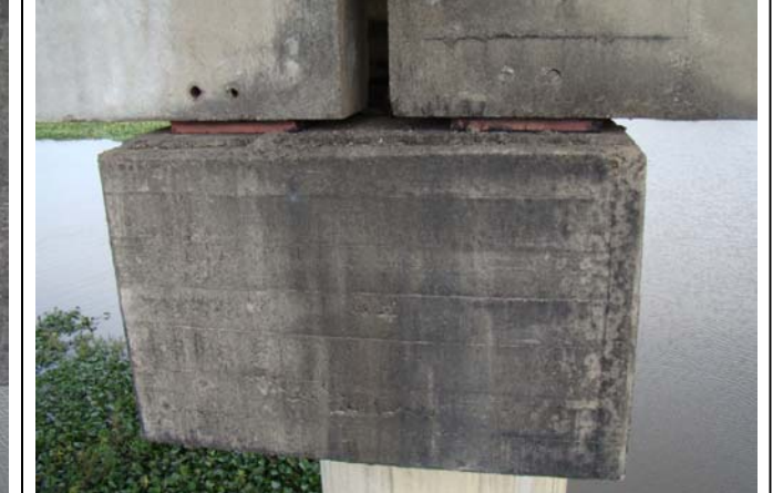
FOTO 6: Fisura en Dintel.
