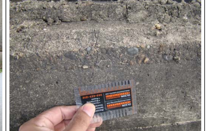
FOTO 6: Fisura en Dintel.
