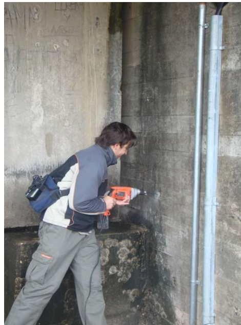
Figura 19. Realización de la perforación para realizar el ensayo de carbonatación sobre la Pila 1 (Estribo 1).
