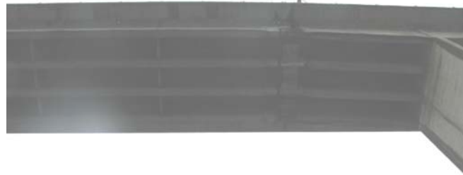
FOTO 1: Cara Inferior del Tablero.
