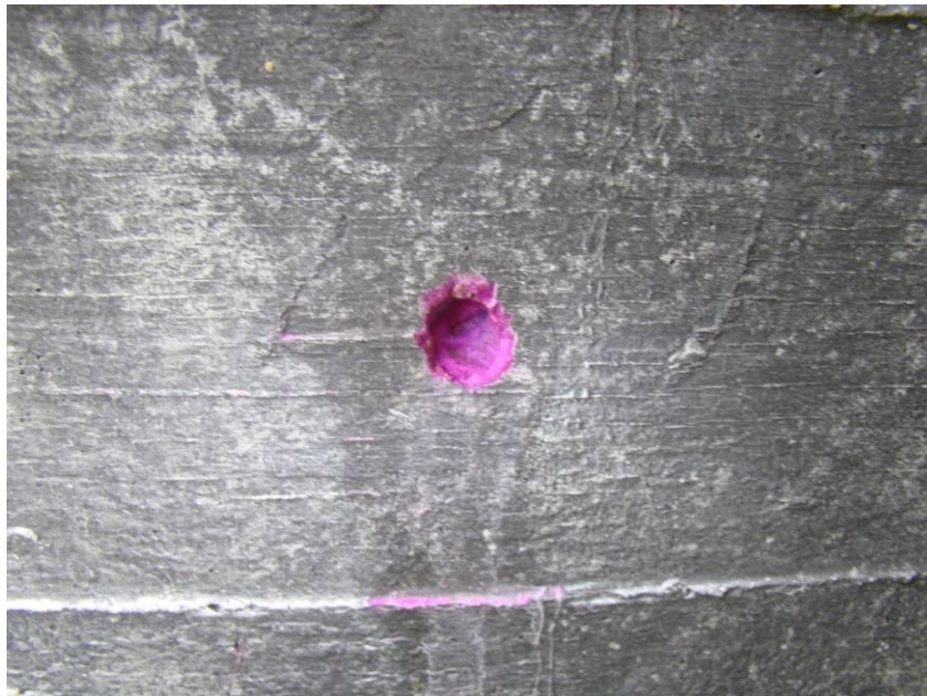
Figura 18. Ensayo de Carbonatación en la Pila 1 (Estribo 1). Se observa que no se presenta carbonatación en la estructura.
