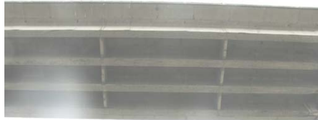
FOTO 1: Cara Inferior del Tablero.
