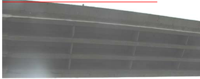
FOTO 1: Cara Inferior del Tablero.
