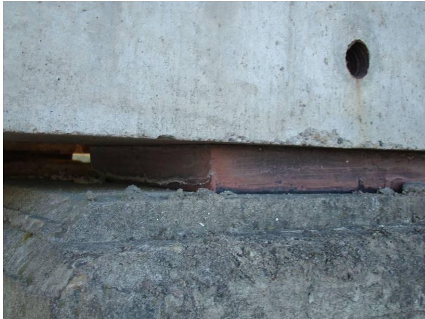
Figura 16. Vista de un dispositivo de apoyo sobre la Pila 49.
