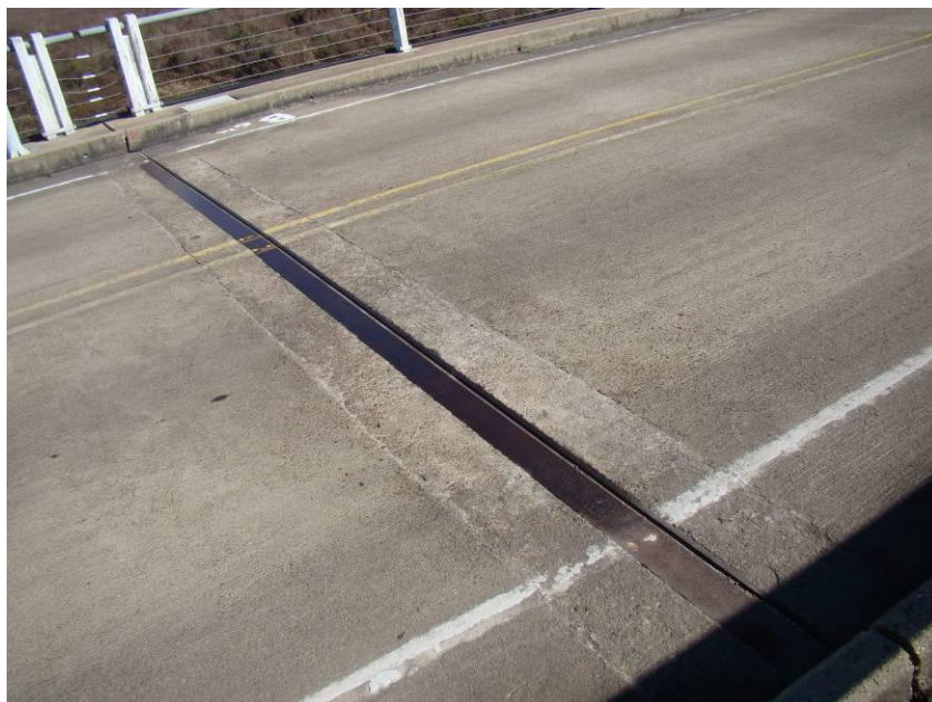
Figura 29. Dispositivos de juntas de dilatación en viaducto.
