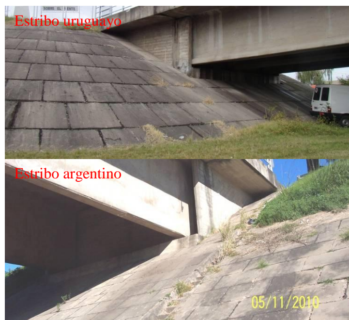
Figura 13. Protección de los terraplenes de acceso.
