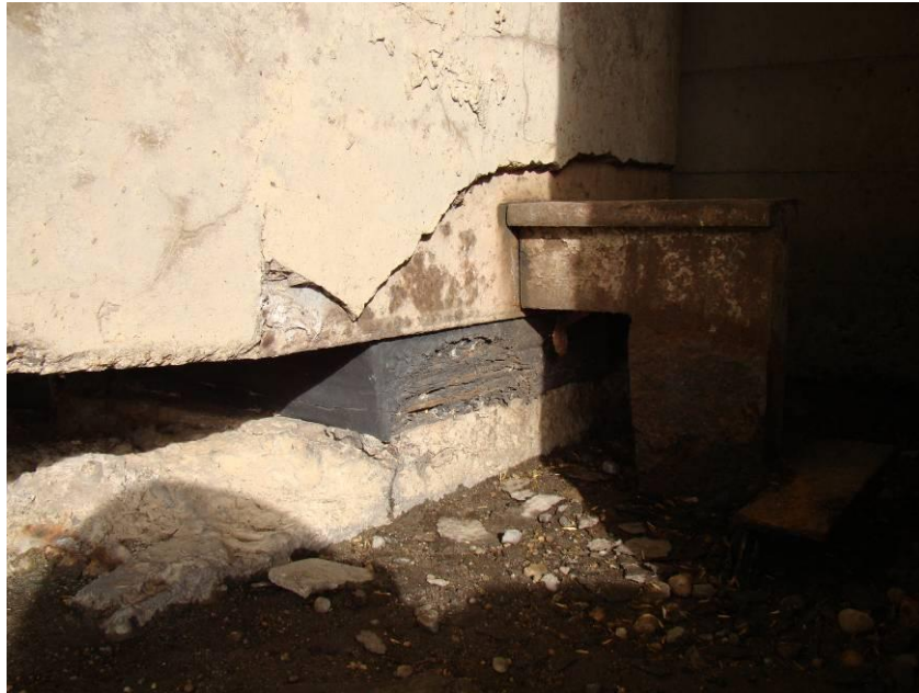
Figura 9. Apoyo sobre el Estribo 2 (Lado Argentino).
